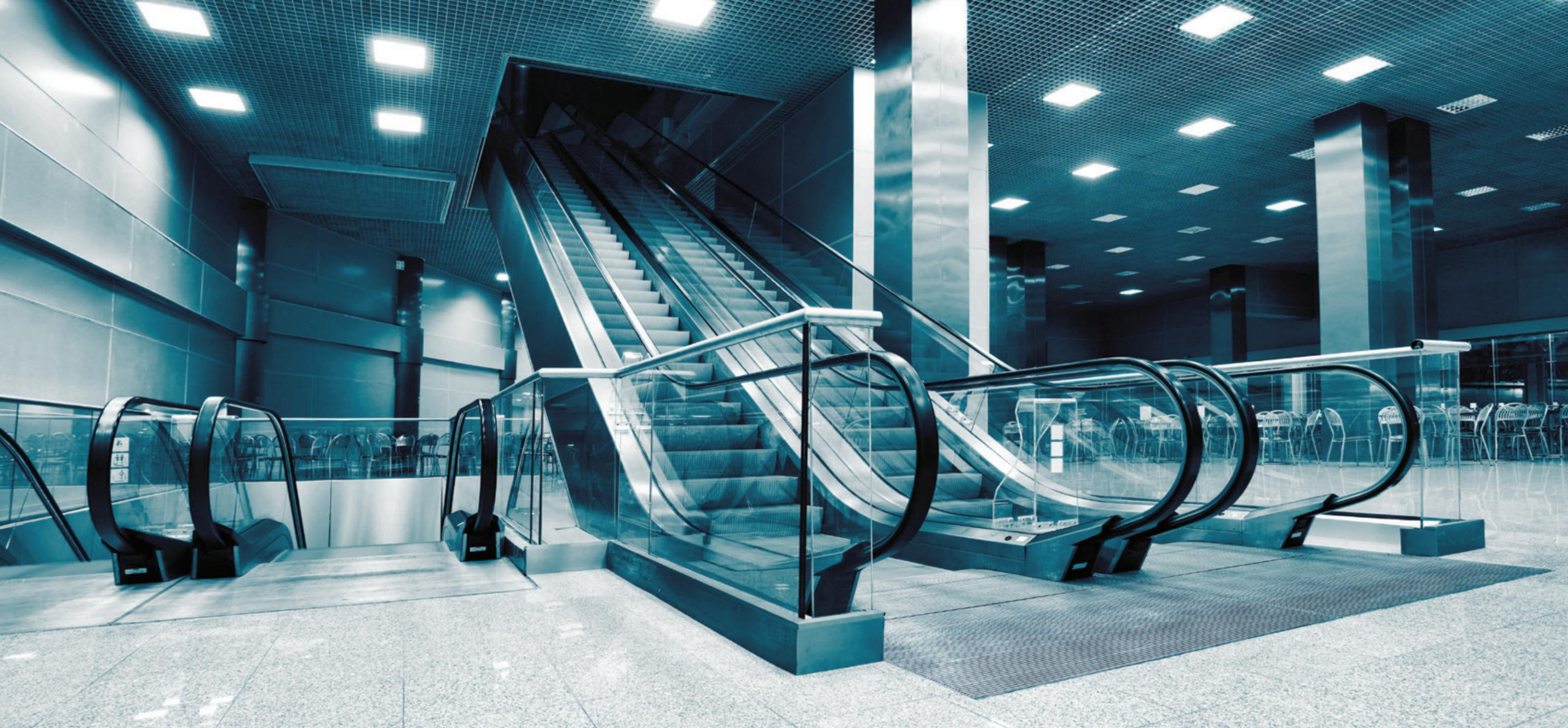
Эскалаторы и пассажирские конвейеры UNGERT обеспечивают высокий уровень безопасности, комфорта и экономии при эксплуатации благодаря использованию передовых технологий. Частотный привод и функция Auto-Start снижает базовое энергопотребление на 30% и оптимизирует работу эскалатора в течение дня, учитывая интенсивность его загрузки.
